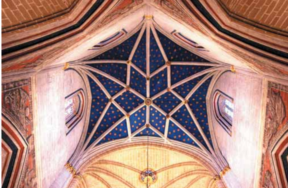
Catedral de Pamplona. Capilla mayor. Bóvedas.
