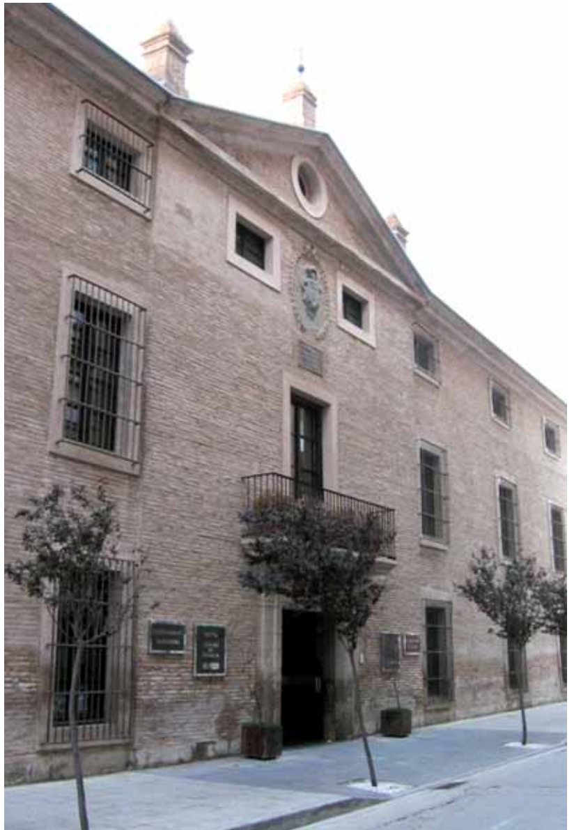
Fachada del edificio fundacional de la Real Casa de Misericordia, hoy transformado en hotel.
