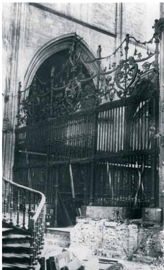
Desmontaje de la reja del coro de la Catedral de Pamplona.
