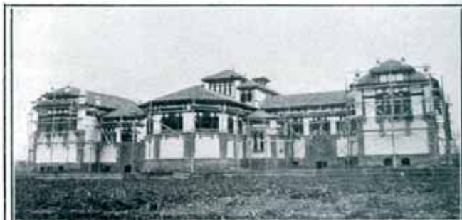
Fachada posterior del edificio
