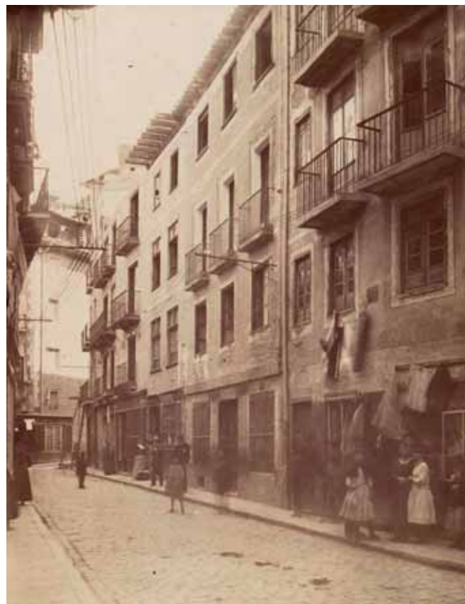
Antigua Calle de las Bolserías. Comienzo del derribo de varias casas para edificar la casa particular, obra del arquitecto Florencio Ansoleaga, situada entre la calle Nueva (nº 2) y calle San Saturnino (nº 1). Copia sobre papel a la albúmina. Archivo Municipal de Pamplona. Fondo “La Avalancha”. Autor desconocido. 1892.
