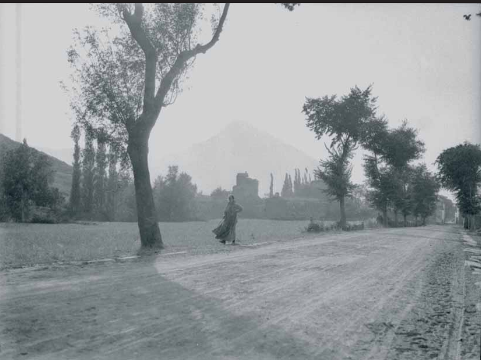
Marqués de Santa María del Villar: Carretera de Idocin , hacia 1920.
