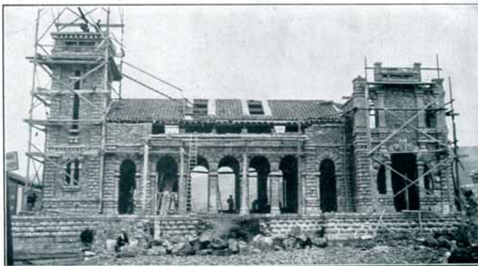
Palacio del Besta-Jira en construcción que se inaugurará á raíz del Congreso (Fotogr. Roldán e Hijo)
