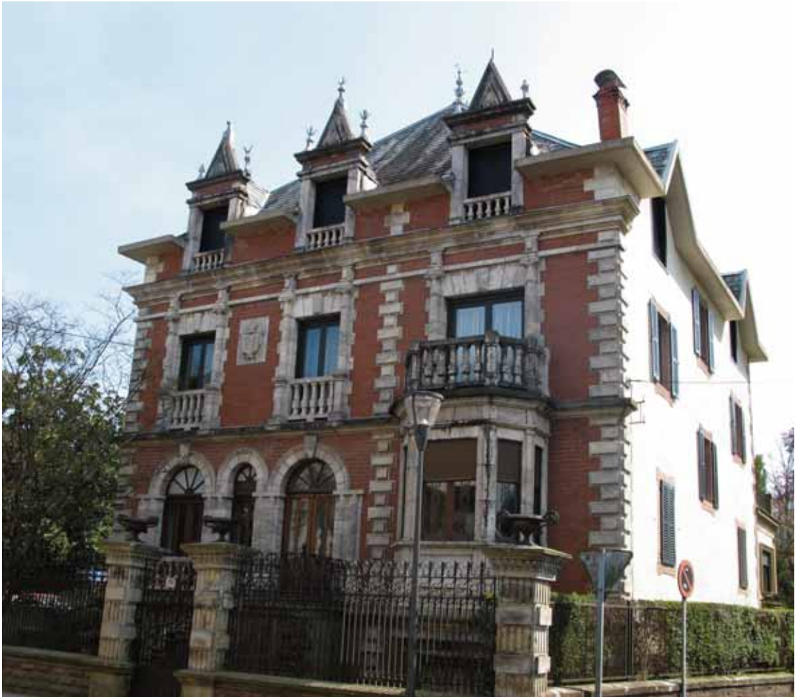
Lám. 24. Casa Manuelenea, Elizondo
