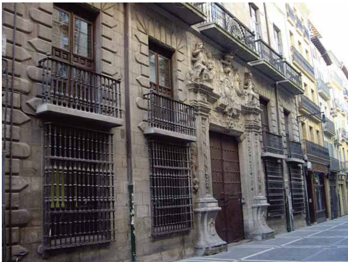
Lám. 27. Casa de los Echeverz, marqueses de San Miguel de Aguayo, en la calle Mayor de Pamplona
