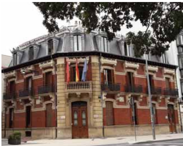
Lám. 29. Edificio de la Cámara de Comercio, Pamplona
