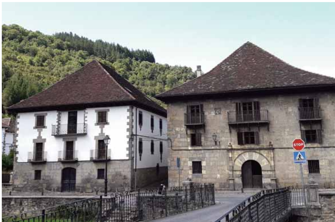
Lám. 54. Casa Boticario y Casa Fortiño, Ochagavía
