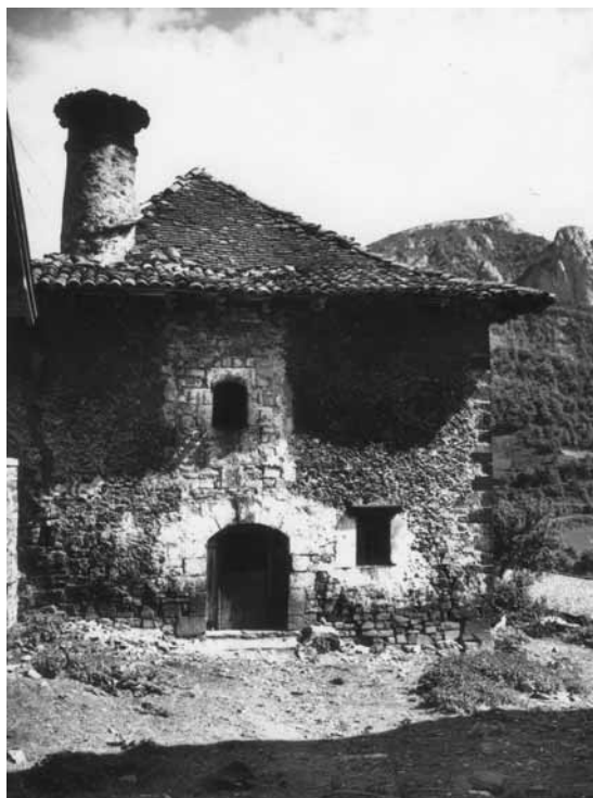
Lám. 79. Desaparecida casa en Isaba con típica chimenea pirenaica
