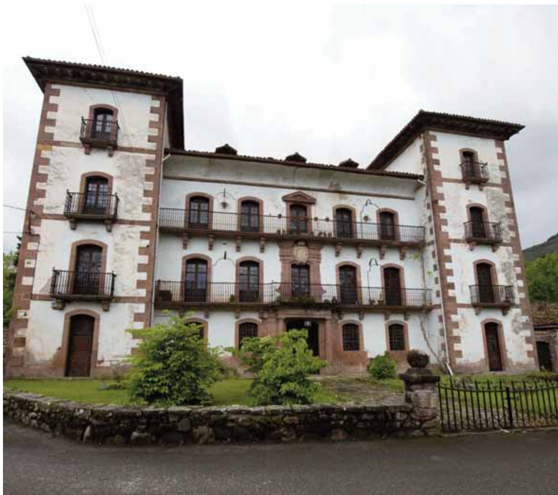
Lám. 23. Palacio Reparacea, Oyeregui
