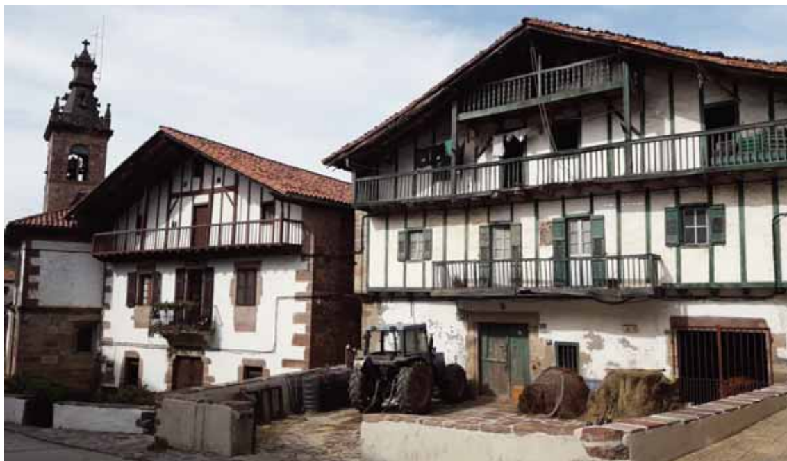
Lám. 31. Grandes aleros protegen las fachadas en las zonas de abundante lluvia, como en Arizcun
