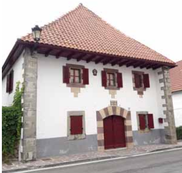
Lám. 38. Casa en la calle San Nicolás, Burguete
