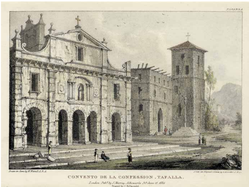
Palacio de los Mencos y convento de la Concepción de Tafalla. William Westall. Views in Spain (1823). Biblioteca Digital de Bizkaia.
