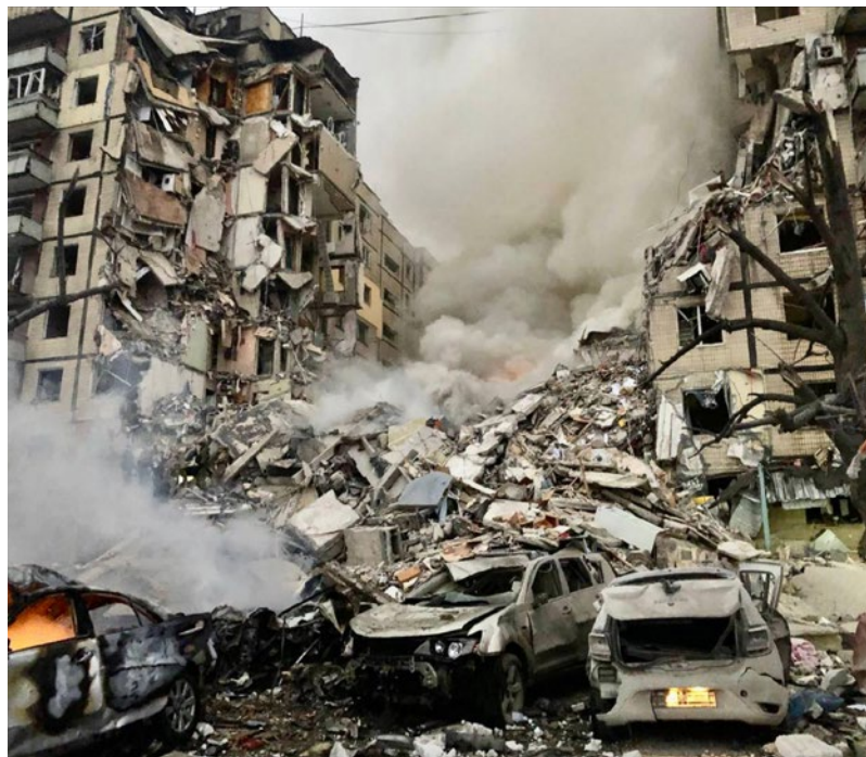
Dstrucción de un edificio de nueve plantas en Dnipro, alcanzado por bombas rusas [V. Reznichenko]
