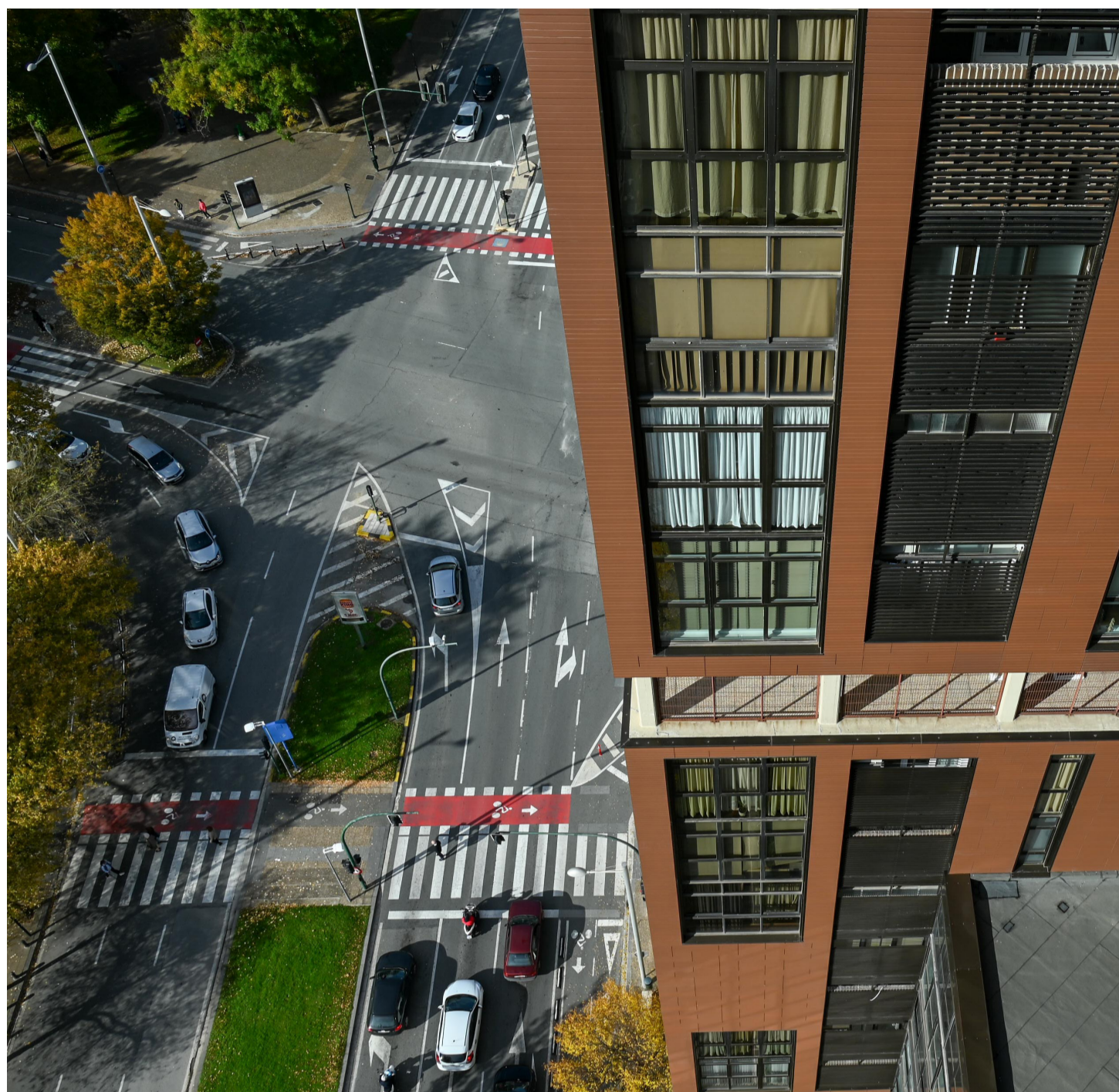
El Edificio Singular es el primer portal de la avenida de Pío XII, frente a la vuelta del Castillo a 70 metros de altura. NOEMÍ IBÁÑEZ
