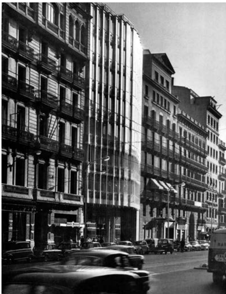
Fig. 1. Edificio Hispano Olivetti en la Ronda de la Universitat. La fachada suavemente ondulada y la severa arquitectura barcelonesa que la rodea. Fuente: "L'Architettura Cronache e Storia" n. 118, 1965, p. 225.
