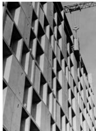
Fig. 6. Marcel Breuer. ZUP de Bayonne. Fotografía de la construcción de la fachada sur, durante la colocación de los paneles prefabricados de hormigón. Photo: Nayzerollas. Cortesía de Marcel Breuer Digital Archive, Syracuse University.
