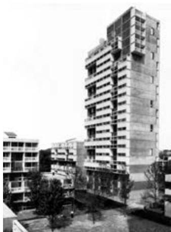
Fig. 5. Josep Lluís Sert. Peabody Terrace. Married Student Dormitories. Fotografía de la Torre X (de orientación este-oeste) insertada en el conjunto. Balcones con brise-soleils en fachada oeste y composición de balcones y huecos verticales en testero sur.
