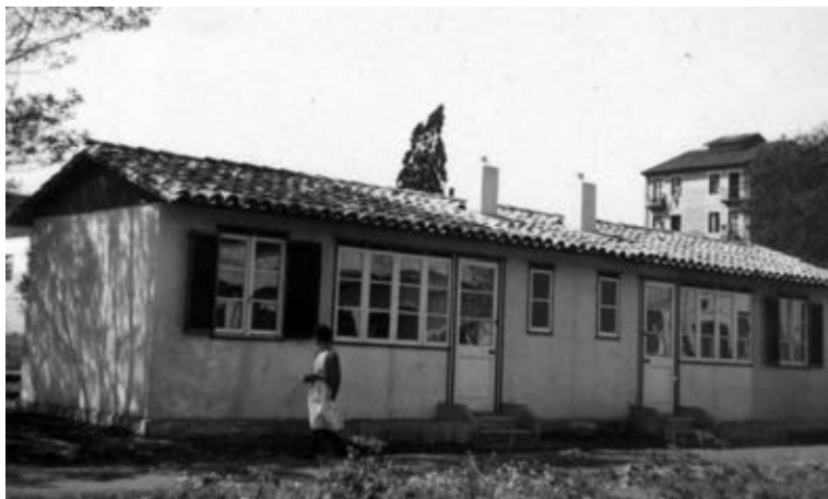
Fig. 7. Vivienda adosada Uni- Seco en Basauri. Fotografía tomada hacia abril-mayo de 1948. AGUN/ 202/ Proyecto 69.
