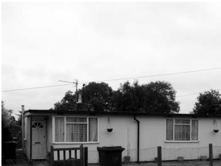
Fig. 3. Estado actual de las viviendas Uni-Seco de la barriada Excallibur en el distrito de Catford en Londres erigidas en 1945-6.
