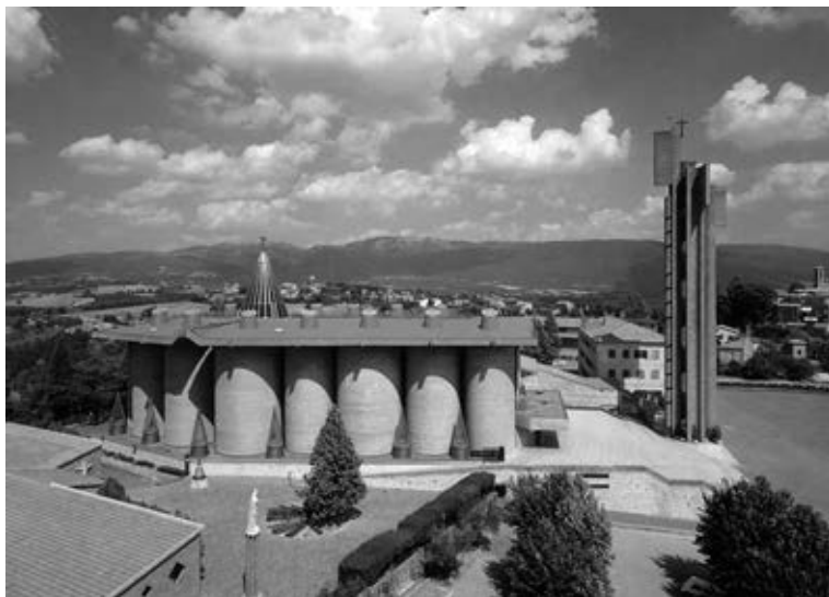
Fig. 2. Santuario de Collevaleza. Vista exterior del conjunto.
