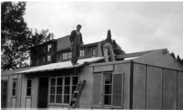
Fig. 6. Montaje de la vivienda adosada Uni-Seco en Basauri en diciembre de 1947. AGUN/ 202/ Proyecto 69.
