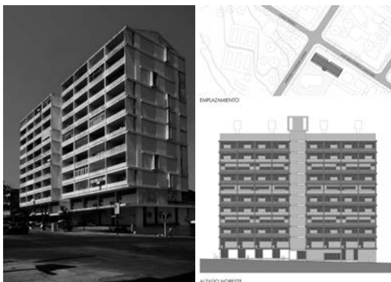
Fig. 5. Bloque Tonelli, Vista sobre el desde la calle da Radio, Maputo. Pancho Guedes, 1954-1957. (Foto: © Inês Lima, 2010).
