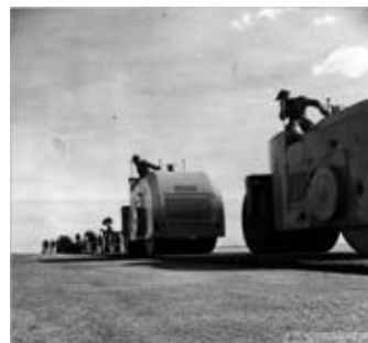
Fig. 2. Maquinaria en la Construcción de la Base Naval de Rota. Localizada en la Biblioteca del Convento de Trinitarios Descalzos, en Alcalá de Henares. Proceden de los Servicios Culturales e Informativos de la Embajada de Estados Unidos en España.
