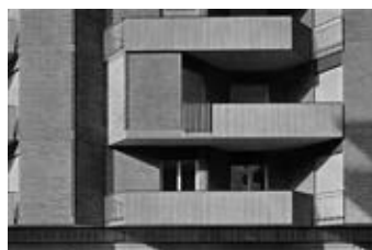
5. Edificio de viviendas Intensivo en el Tuscolano, 1965. Vista exterior, detalle fachada.
