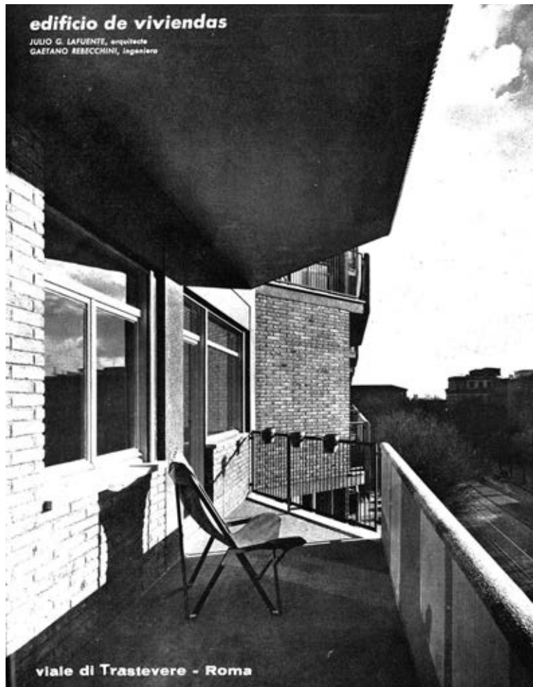
2. Edificio de viviendas Intensivo en viale Trastevere, 1957. Vista exterior del balcón.
