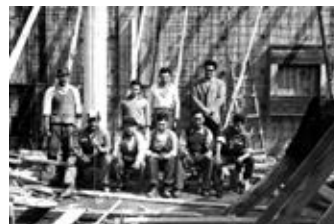
3. Fotografía de Jesús Bermejo, situado el primero por la derecha en la segunda fila, con algunos obreros en la obra del edificio Copelec en Chillán. Probablemente data del año 1964 o 1965 (Fondo Juan Borchers del Archivo de Originales Sergio Larrain Garcia-Moreno de la Pontificia Universidad Católica de Chile).
