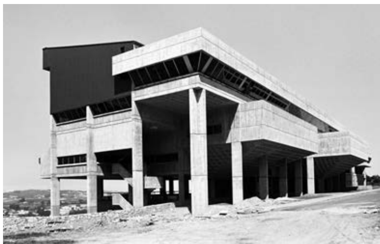
Fig. 3. Escuela de Aparejadores en construcción.
