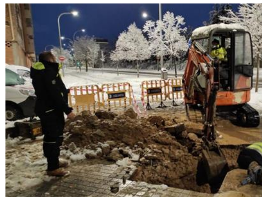
Ilustración 10 - Trabajos de reparación de Aquara en Calatayud en una avería producida el sábado por Filomena [42]
