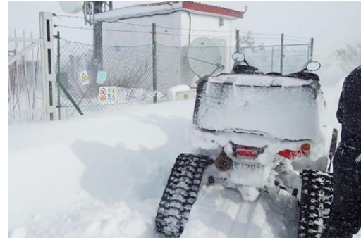
Ilustración 13 - Las telecomunicaciones han resistido a «Filomena» gracias a los trabajadores que aseguran las redes [47]
